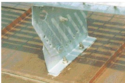
Крепление средств обеспечения безопасности на крыше с помощью болтов, изготовленных из нержавеющей стали и изолированных от кровли свинцовым листом.
