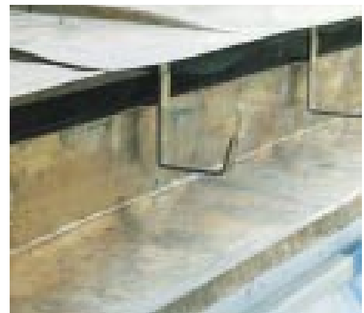
Пример защитных отливов (водосточные желоба еще не установлены).
