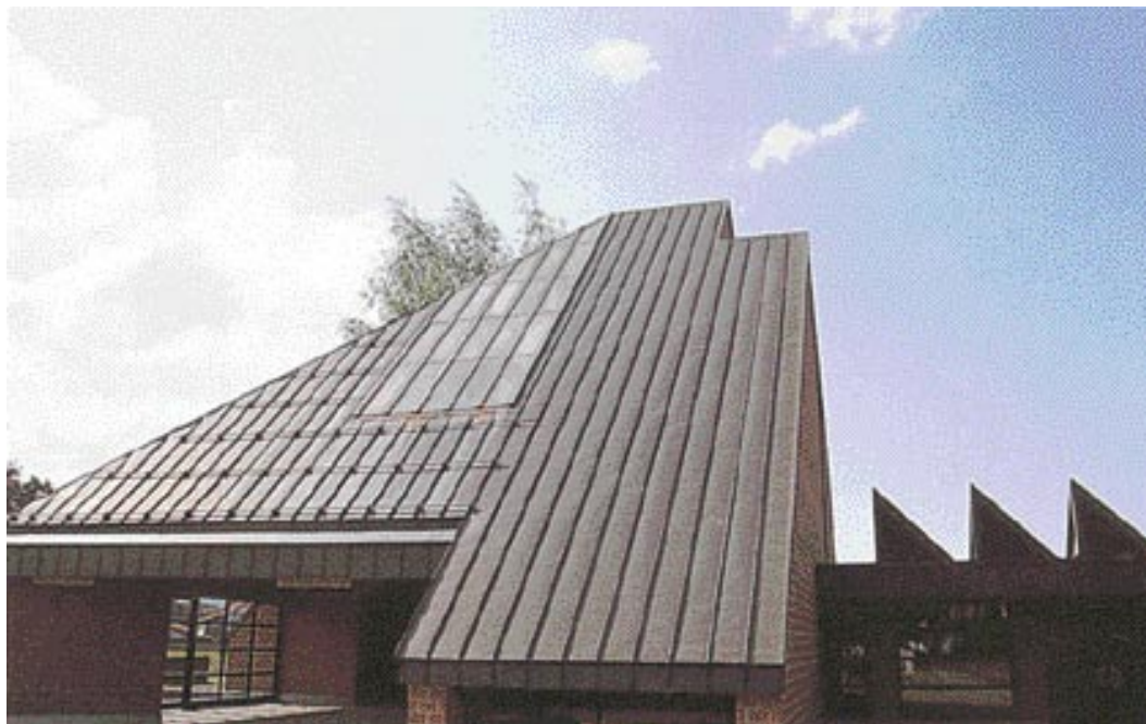
Крепление направляющей конька крыши с фальцевым соединением, которое не препятствует перемещению кровельного покрытия. Имеется множество разных видов фальцевого соединения.
