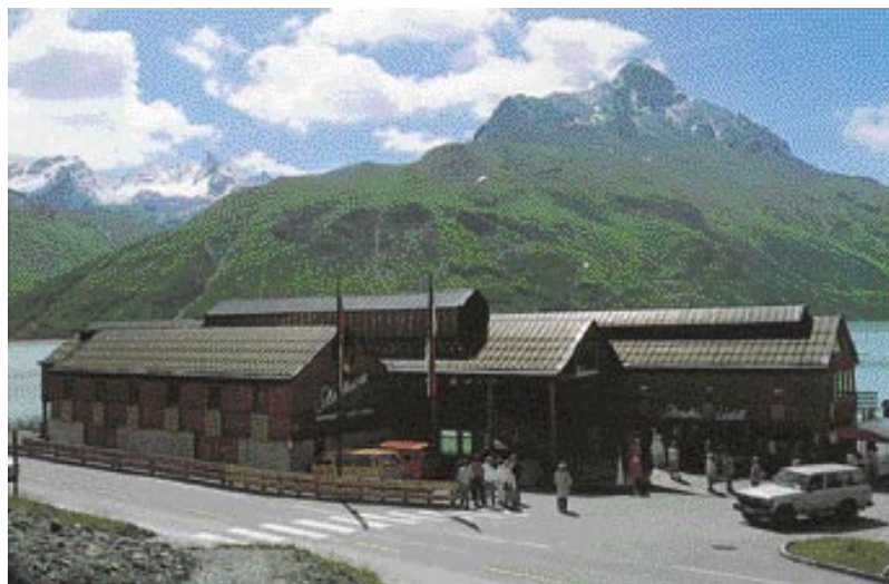
Защита от снежного оползня над входом
