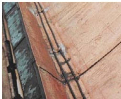
Образование льда на карнизах может быть предотвращено в некоторой степени путем применения греющего электрокабеля. Однако важно сразу спроектировать крышу так, чтобы предотвращалось образование льда.
