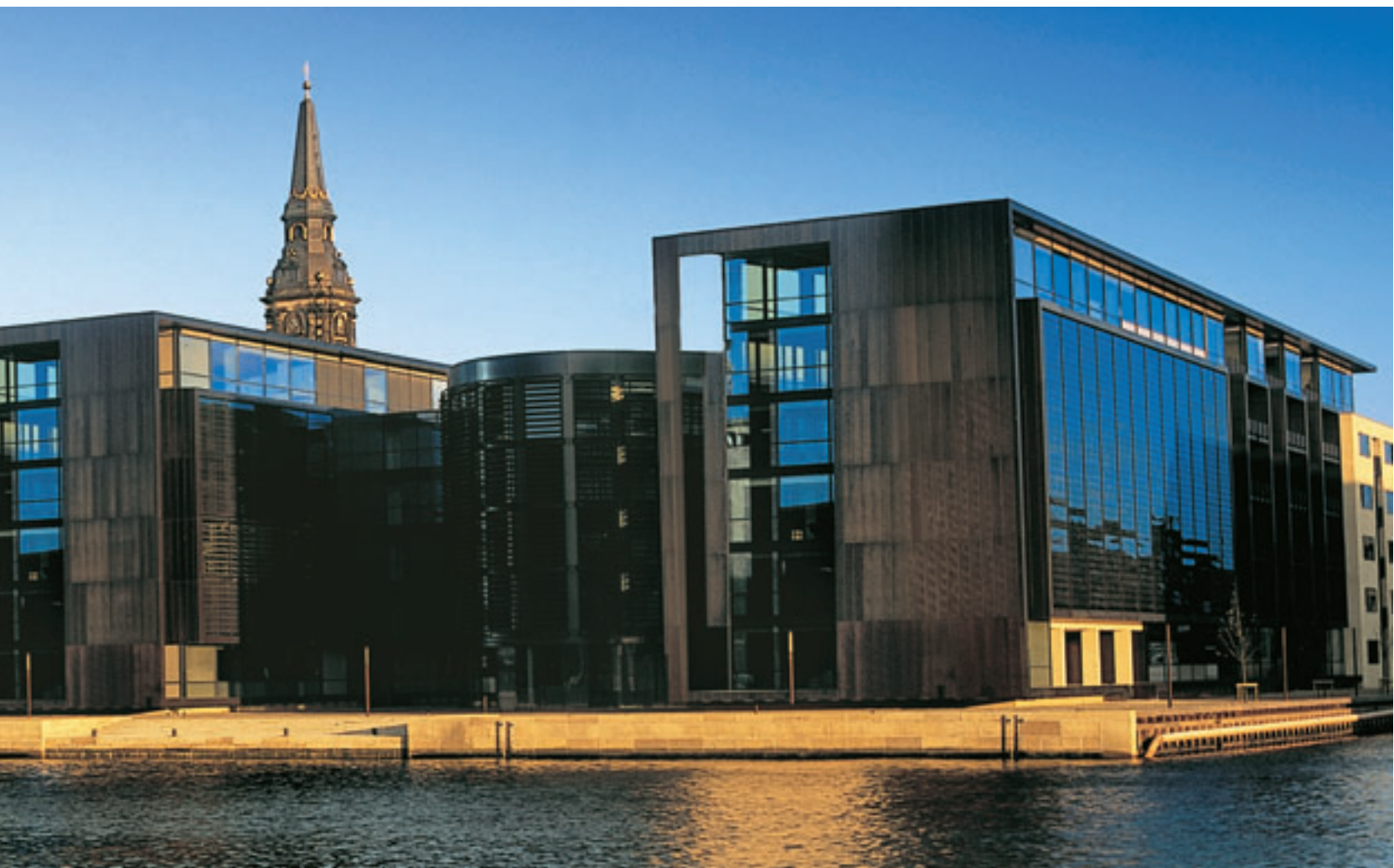
Банк, Копенгаген, Дания Фасады, облицованные медью по методу Nordic Brown TM
