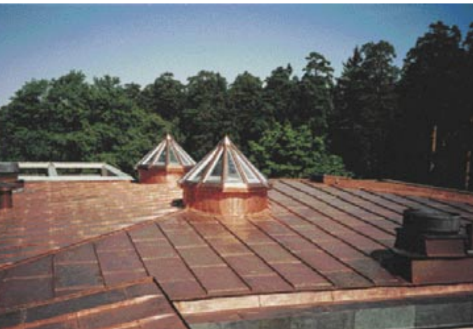
Медь, используемая для покрытия крыши, чаще всего - это раскисленная фосфористая медь.
