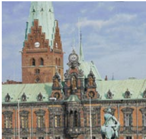
Медные кровельные покрытия имеют несравнимый ни с чем срок службы. Никто не знает, какого возраста может достигнуть медная кровля. Фотография ратуши в Мальмё, Швеция.
