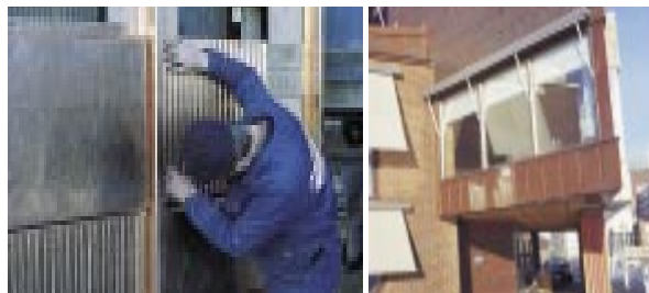
Монтаж медных кассет
