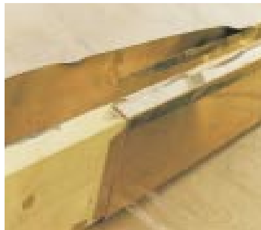
Дерево используется в качестве рамы для водосточных желобов
